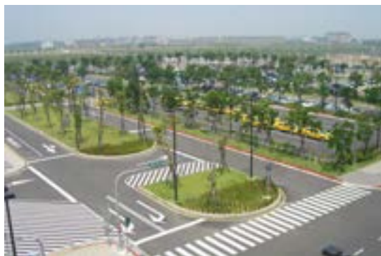
圖 3 高鐵台南車站特定區鳥瞰照片
