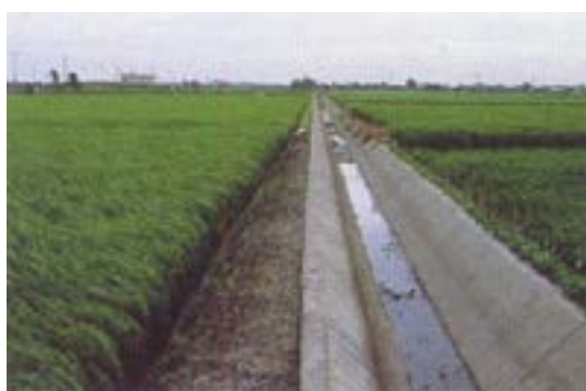
圖 6 農地重劃生態工法梯形內面工
