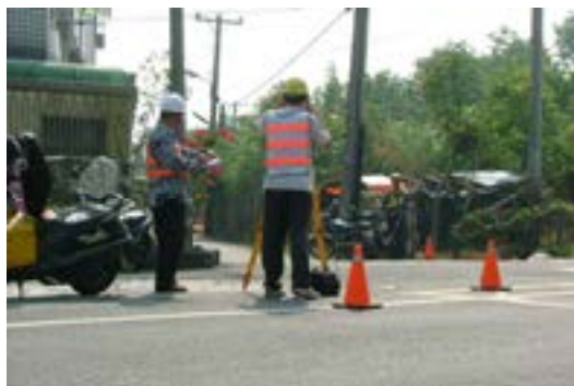
圖 9 現場樁位測定實況
