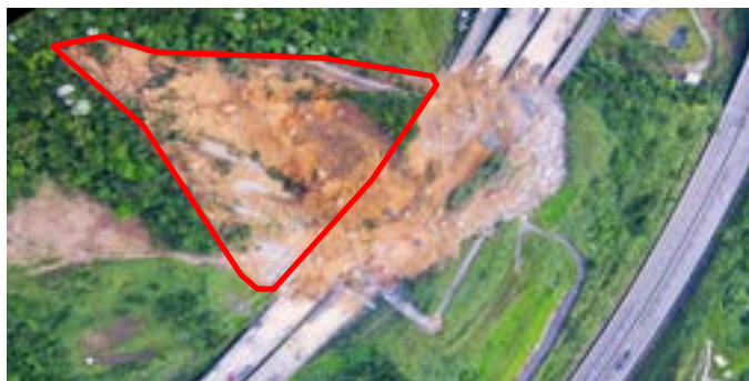
圖12 崩塌區域邊界圖
