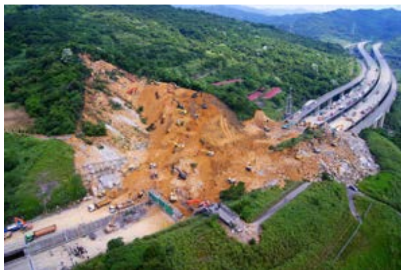
圖6 旋翼型UAV北二高崩場地側拍圖(飛虎、智飛科技公司提供)
