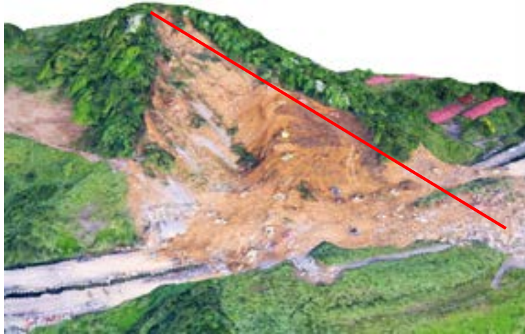
圖17 崩塌地縱斷剖面線
