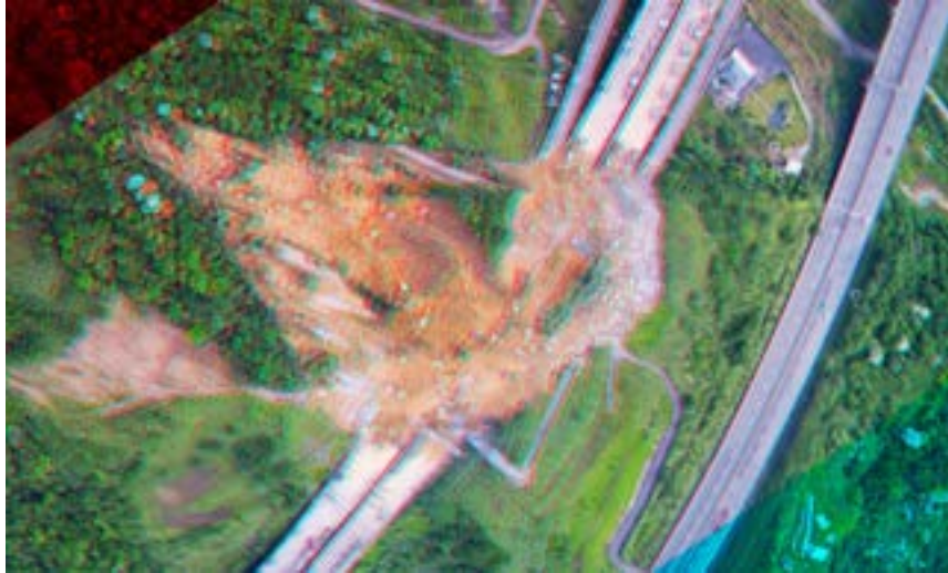
圖14 崩塌地紅綠影像
