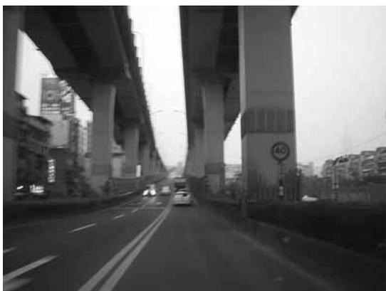
圖 3 高架與平面道路重疊及上下匝道例
